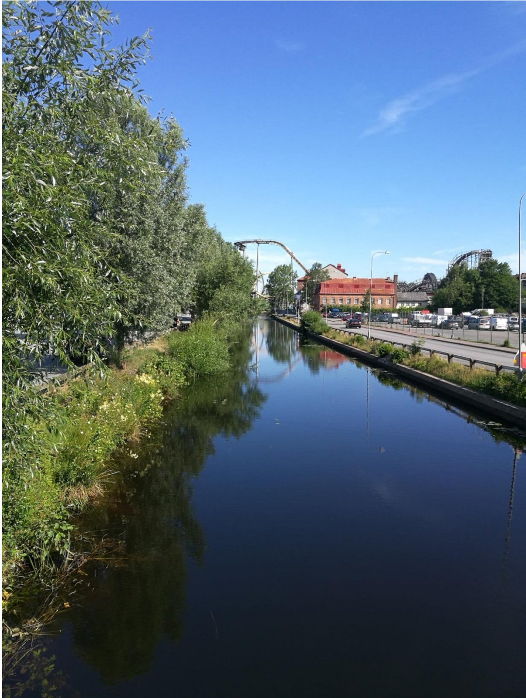
Figur 6. Norr om Vörtgatans bro (sektion D). Lodrät mur, naturlig strand saknas. Nellickevägen går längs ån. Foto taget mot norr.
